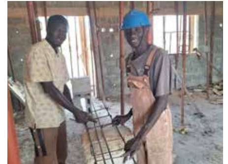
Erst vor wenigen Tagen wurden die Schalung für die Betondecke fertig gestellt, die Eisenträger gebunden und eingelegt © Verein Gambia-Sponsoring
