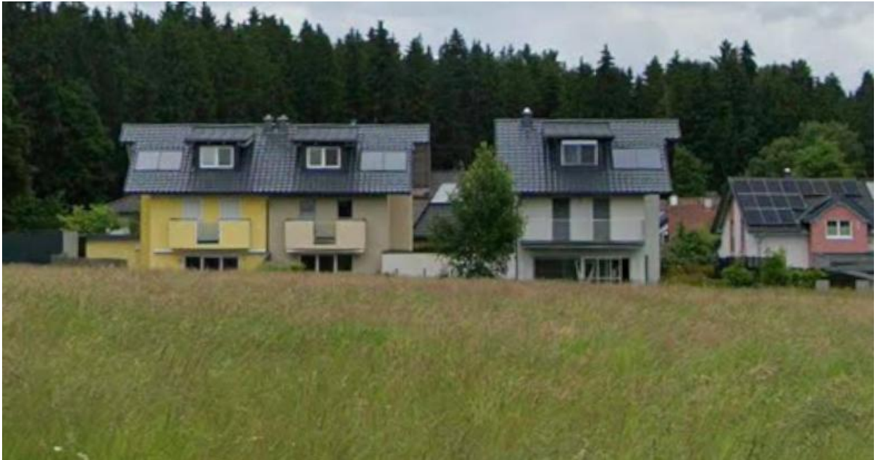
Abb. 6: Blick auf die betroffenen Gebäude - ausgehend von Obertrumer Landesstraße
