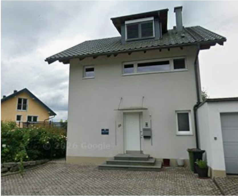
Abb. 8: Nord Ansicht betroffenes Gebäude
