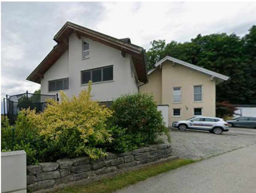
Abb. 7: Ost Ansicht betroffenes Gebäude
