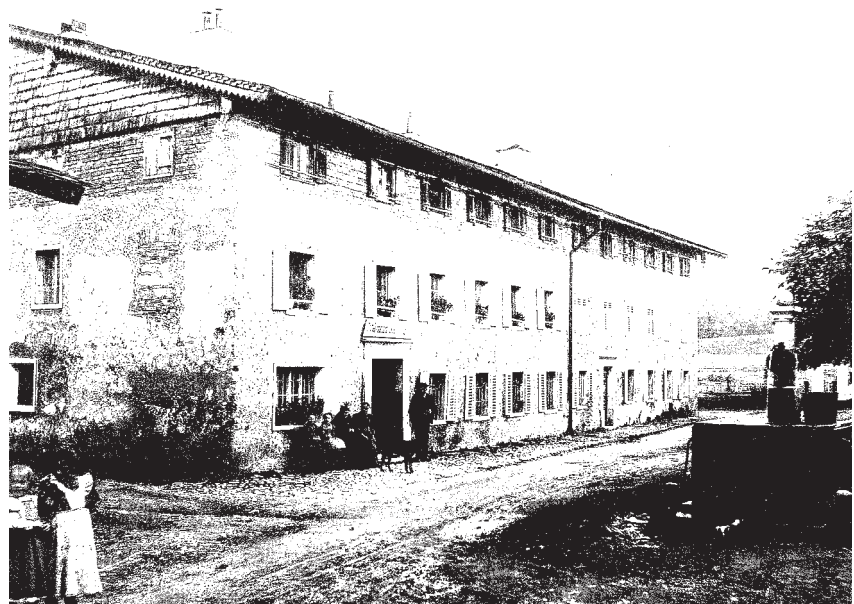
Im marktauswärts (rechts) gelegenen Teil des „Unterbäck“ (Hauptstraße 18) war ab 1862 die Poststation Seekirchen untergebracht; am rechten Bildrand der alte Brunnen am Untermarkt (Aufnahme vom Ende des 19. Jahrhunderts)
