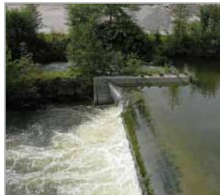
Die Anlage könnte ca. 7.500 Stunden im Jahr „grünen“ Strom erzeugen und käme auf eine Engpassleistung von 30 kW. Man würde mehr als 155.000 kWh pro Jahr erzeugen und könnte 32 Haushalte versorgen. Bild: Eisl-Berger
