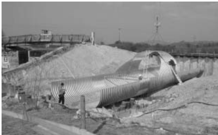
Montage des Wellblechdurchlasses
