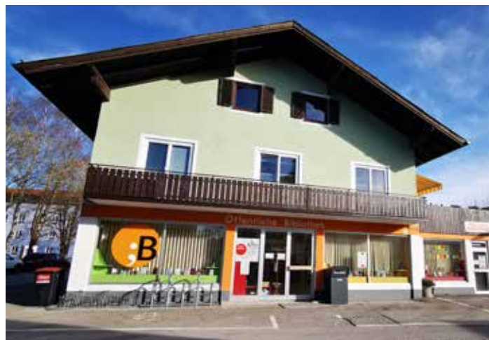
Die große graue Box neben dem Eingang ist die neue Rückgabestation. © Eisl-Berger
