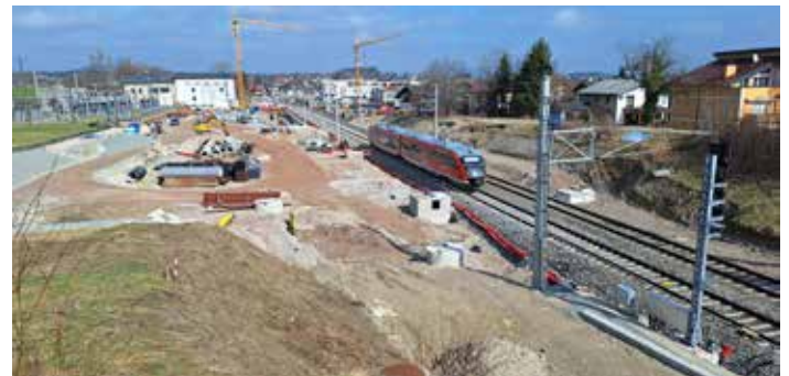
Die Bauarbeiten sind im Projekt-Fahrplan | © ÖBB/Öppinger
